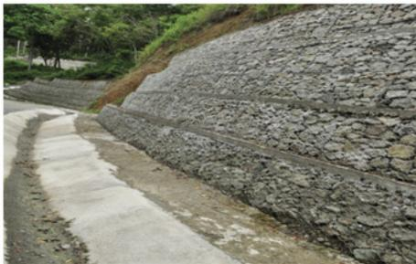
El gavión protege contra la erosión acelerada contribuyendo a la reforestación, a la recarga de mantos acuíferos y se puede conducir el agua para riego de terrenos de cultivo.
