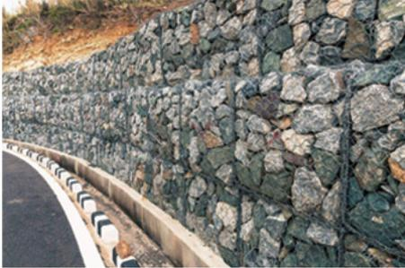
Los muros de gaviones trabajan a gravedad, son flexibles y contrarrestan los empujes, se utilizan para mantener la diferencia en los niveles de suelo de sus dos lados. También pueden ser diseñados anclados con malla triple torsión si las características de la obra lo permiten.
